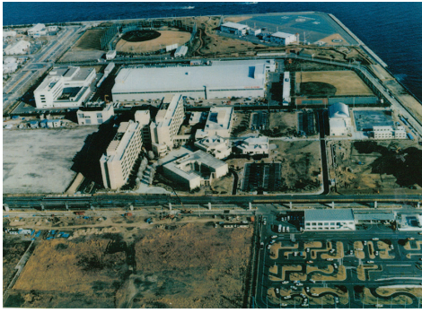
1980年頃の金沢埋立3号地
