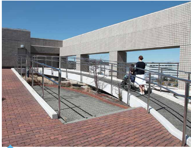
7F 屋上スロープ
